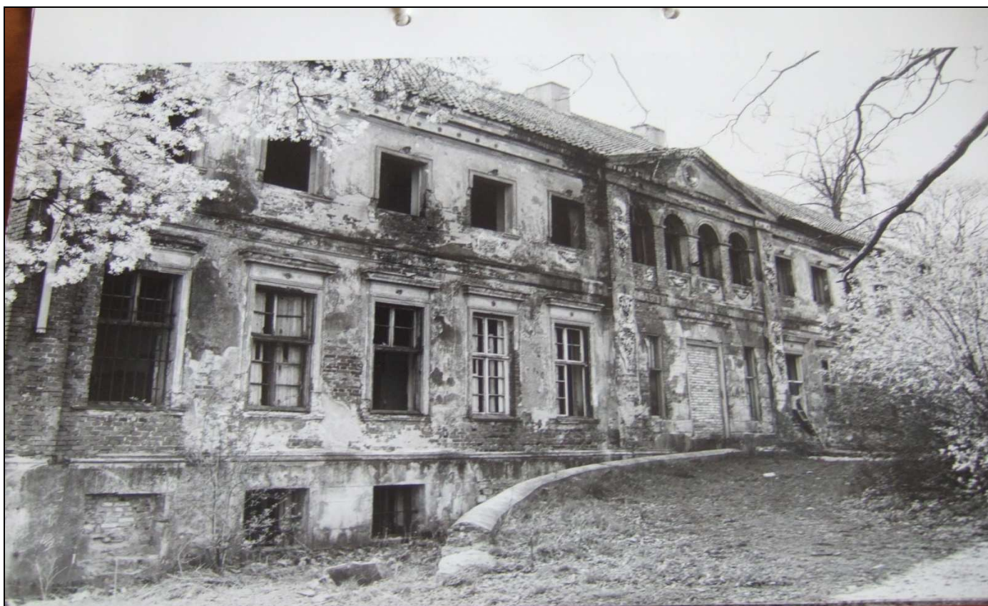
Nadeszły mroczne lata 80-te – zamurowane wejście główne.
