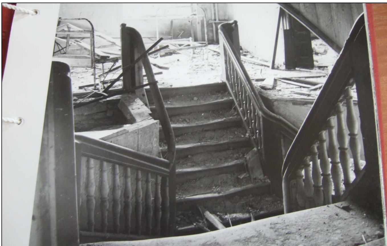
To były piękne dębowe schody z parteru na piętro – foto u góry i poniżej.
